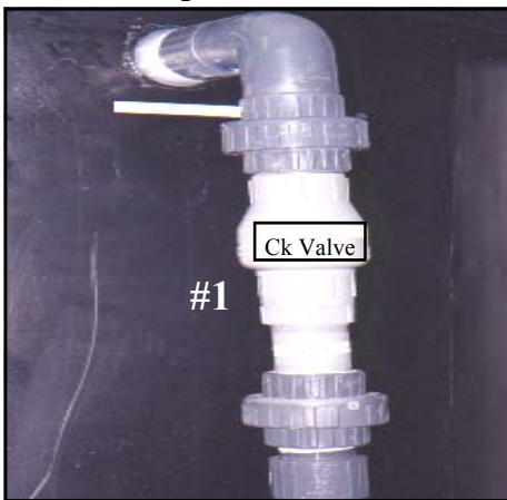
Inlet port w/check valve
