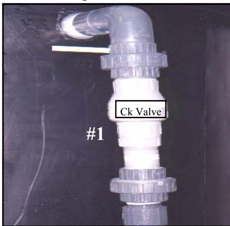
Inlet port w/check valve
